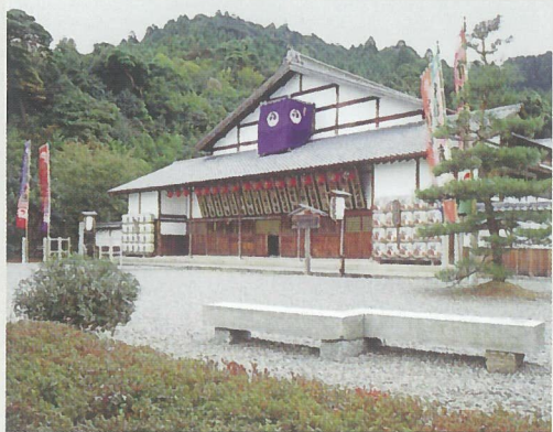
旧金毘羅大芝居(金丸座) Konpira Oshibai Kabuki Theater (KANAMARU-ZA)
