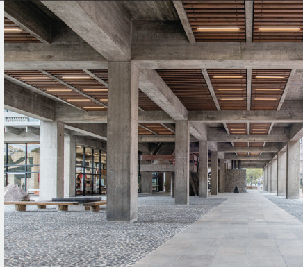
▲ピロティは、「県民に開かれた空間」と言われる通り、立ち寄り人たちの憩いの場となっている
