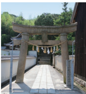
八幡神社の石鳥居 〈県有形文化財〉 八幡神社参道入口に建つ明神鳥居。直島産の花こう岩でできており、高さ3.86m、柱の直径50cm。八幡神社は高原次勝が慶長6年（1601）に再興したと伝わります。懸額裏の刻印から、その翌年の建立ではないかと推測されています。
